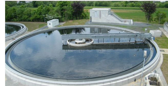
Nachklärbecken 1 der Kläranlage Limburg/Staffel
