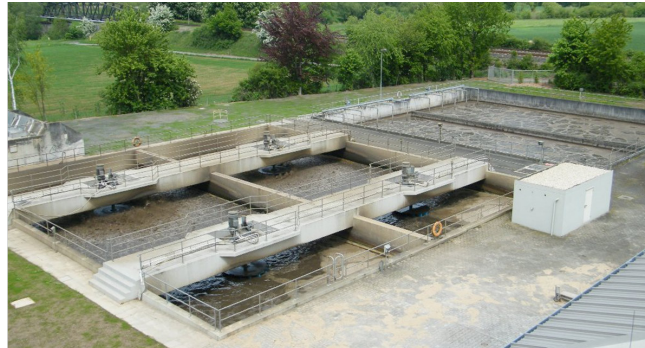
Belebungsbecken der Kläranlage Limburg/Staffel
