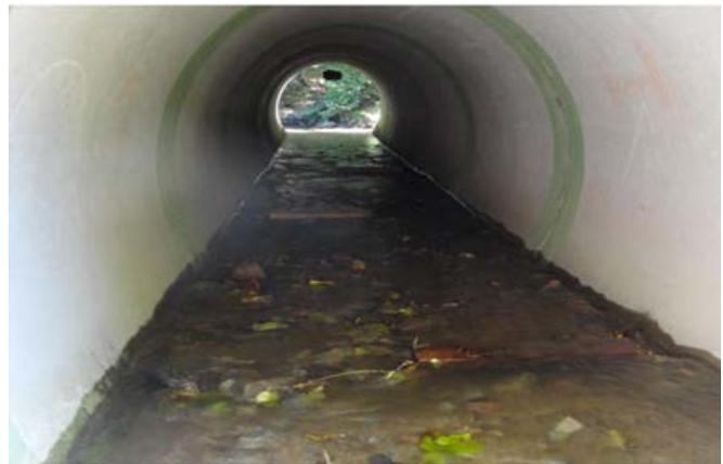
Abbildung 24: Vorher (links): Fehlende Substratauflage im Rohrdurchlass (2010), Nachher (rechts): Versetztes Aufdübeln von halblangen Querriegeln (Holz) und Einbringung von Kies/Schotter (2016). Lage: Wurzelbach (Hoxhohl), Quelle: WRRL-Viewer WH-ID: 100629
