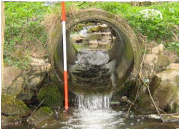
Abbildung 3: Rohrdurchlass mit Absturz (Quelle: wrml.hessen.de, WH-ID 22027)
