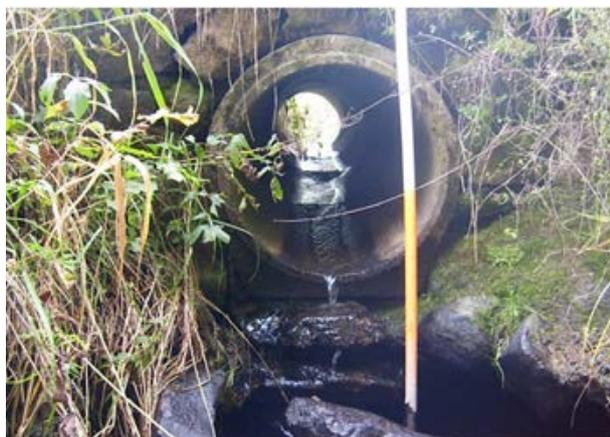
Abbildung 5: Verrohrung mit geringer Wassertiefe (Quelle: wrrl.hessen.de, WH-ID 94277)
