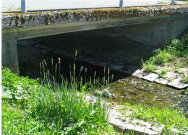
Abbildung 1: Massiv befestigte Sohle unter Rahmen-durchlass (Quelle: wrml.hessen.de, WH-ID 23833)
