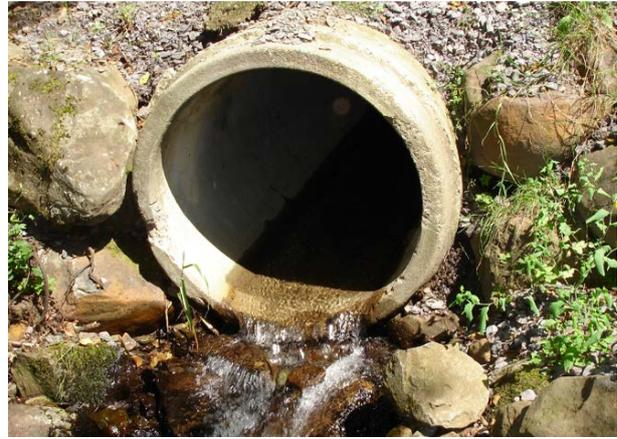
Abbildung 2: Rohrdurchlass ohne Substratauflage (Quelle: wrml.hessen.de, WH-ID 20812)
