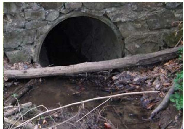
Abbildung 6: Treibgut am Einlass von einem Durchlass (Quelle: wrrl.hessen.de, WH-ID 10884)
