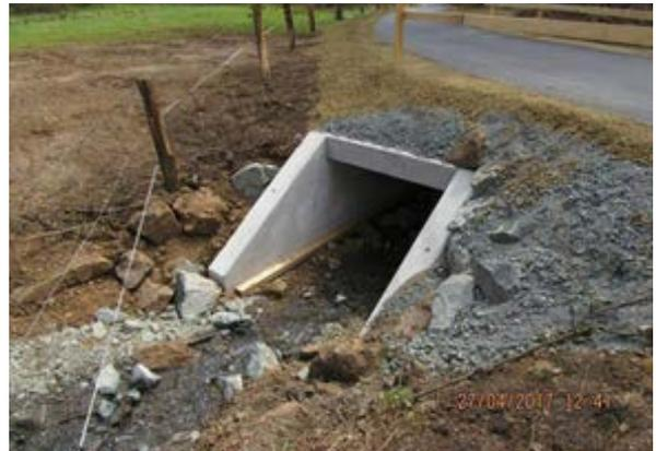
Abbildung 10: Vorher (links): Durchlass mit geringer lichter Weite und Absturz (2007), Nachher (rechts): Kastendurchlass mit offenem Profil, Trockenbermen, Steinschüttung und vergrößerter lichter Weite (2015). Lage: Siegenbach (Weilburg-Drommershausen), Quelle: WRR-Viewer WH-ID: 61199
