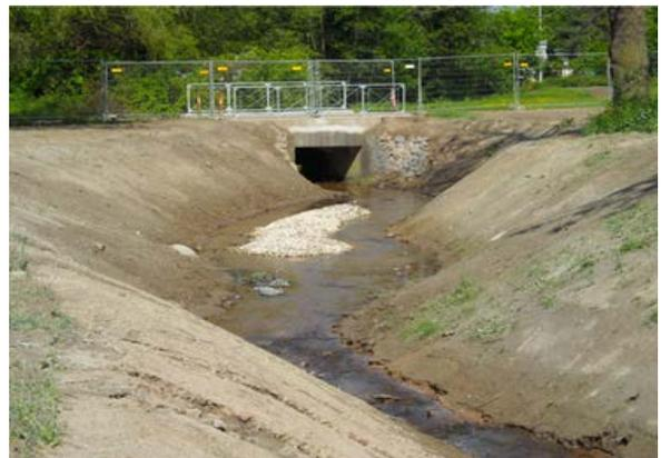
Abbildung 40: Vorher (links): Betonierte Furt mit Absturz (2007), Nachher (rechts): Entfernung der Betonsohle und Einbringung einer Steinschüttung im Unterwasser (2018). Lage: Bracht (Schlierbach), Quelle: WRRL-Viewer WH-ID: 36007
