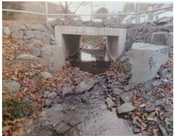
Abbildung 11: Vorher (links): Rohrdurchlass mit geringer lichter Weite und befestigter Sohle (2007), Nachher (rechts): Kastendurchlass mit offenem Profil, größeren lichten Weite und Steinschüttung im Unterwasser (2015). Lage: Grundbach (Weilburg-Drommershausen), Quelle: WRR-Viewer WH-ID: 61200
