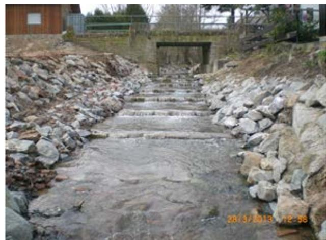
Abbildung 35: Vorher (links): Raue Rampe (Wasserspiegeldifferenz 80 cm) im Unterwasser einer Brücke (2007), Nachher (rechts): Raugerinne mit Beckenstruktur (2013). Lage: Kinzig (Nieder- Kinzig), Quelle: WRRL-Viewer WH-ID: 19484
