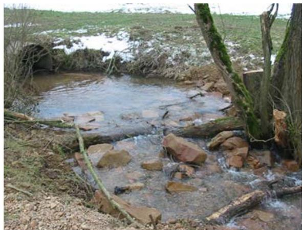
Abbildung 29: Vorher (links): Kleiner Absturz (10 cm) unterhalb einer Wiesenverrohrung (2007), Nachher (rechts): Sohlhebung im Unterwasser mit Holzschwellen und Störsteinen (2019). Lage: Josbach (Halsdorf), Quelle: WRR-Viewer WH-ID: 21538
