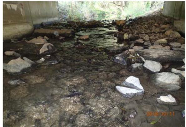
Abbildung 38: Vorher (links): Massivsohlenabschnitt unter Durchlass (2007), Nachher (rechts): Aufwertung der Sohle durch Einbringen von Steinstrukturen und Sohlsubstrat, Einbau von aufgedübelten Querbalken, (2011). Lage: Lauter (Frischborn), Quelle: WRRL-Viewer
