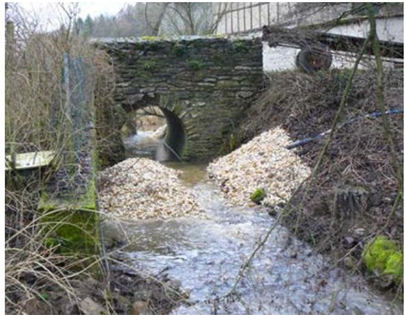
Abbildung 28: Vorher (links): Kleiner Absturz (10 cm) unterhalb des Durchlasses (2007), Nachher (rechts): Anhebung des Unterwassers und Anlegen von Geschiebedepots (2014). Lage: Laubusbach (Münster), Quelle: WRR-Viewer WH-ID: 51600
