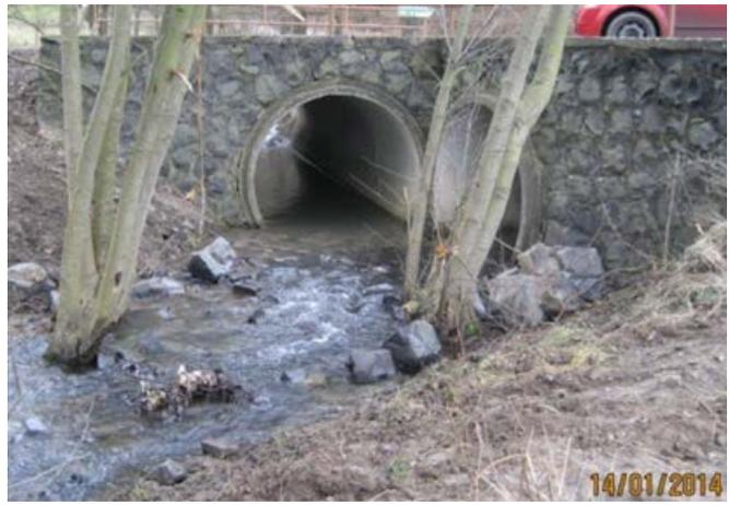
Abbildung 23: Vorher (links): Rohrdurchlass ohne Substratauflage und geringer Wassertiefe (2007), Nachher (rechts): Einbringung von Sohlsubstrat unterhalb sowie im Rohrdurchlass (2014). Lage: Eisenbach (Selters), Quelle: WRRL-Viewer WH-ID: 51829
