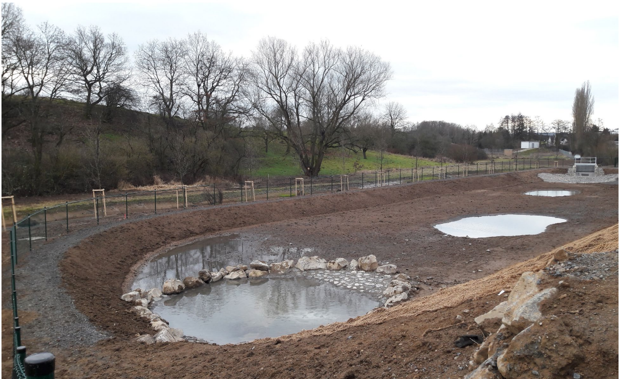
Abbildung 7: Neu geschaffenes Regenrückhaltebecken. © RP Gießen
