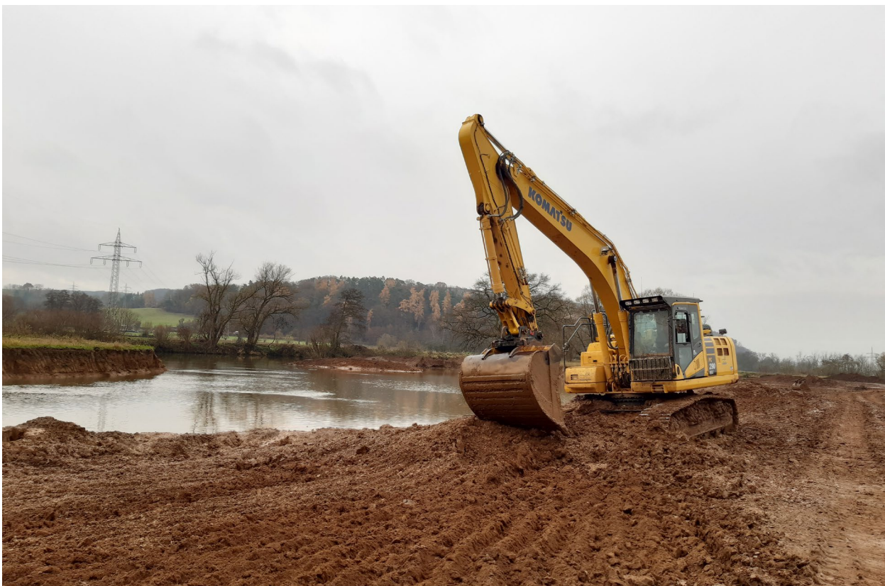
Abbildung 3: Profilierung der Lahnufer mit schwerem Gerät. © RP Gießen
