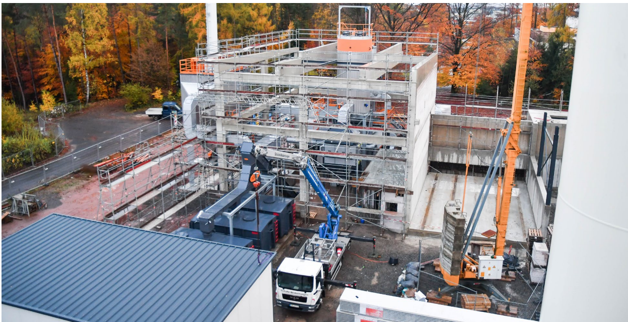
Abbildung 13: Das im Bau befindliche Biomasseheizwerk auf den Lahnbergen in Marburg, November 2019 © Christina Mühlenkamp.
