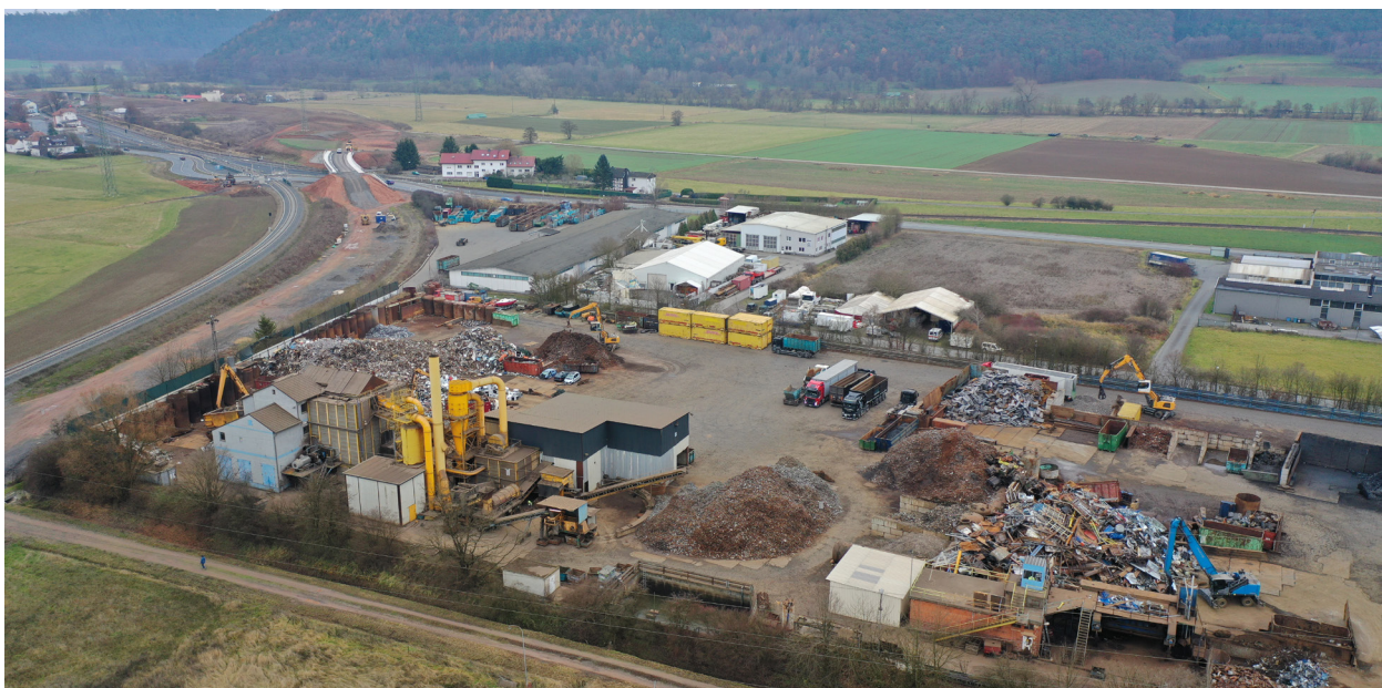
Abbildung 15: Luftbild der Gesamtanlage in Lahntal-Goßfelden.
