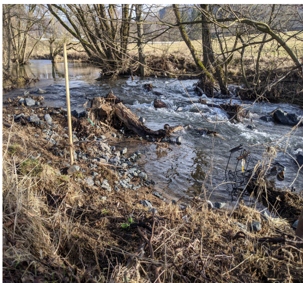
Abbildung 4: Diese neu angelegte raue Rampe sorgt nun für Durchwanderbarkeit der Dietzhölze. © RP Gießen
