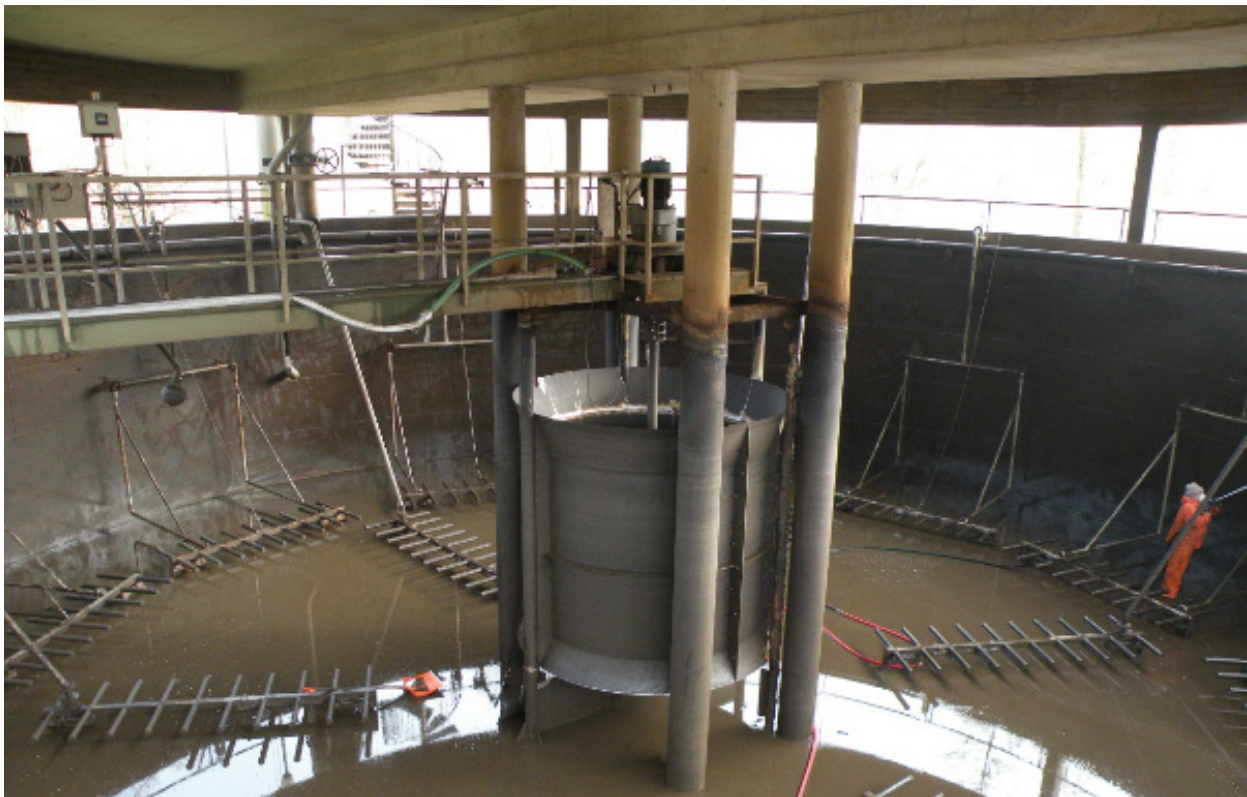
Abbildung 10: Belebungsbecken der Kläranlage Lauterbach während Wartungsarbeiten.
