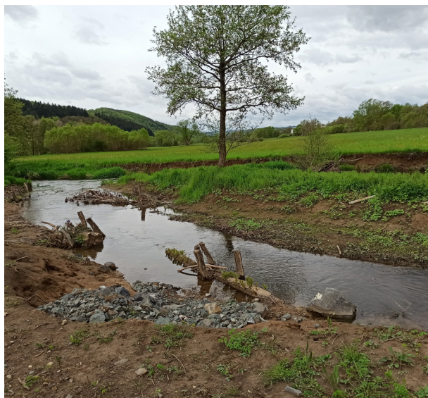
Abbildung 3: Eine neu angelegte Hochflutmulde an der Dietzhölze. © RP Gießen
