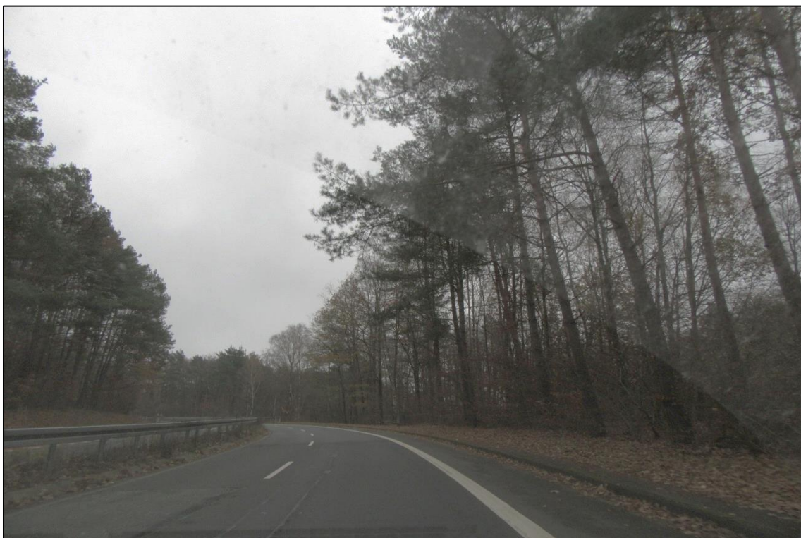
Abbildung 5: Untersuchungsabschnitt 2 im Bereich des angrenzenden Waldrandes
